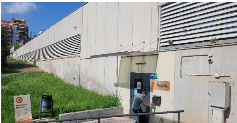
Aparcament amb secció encastada – 07.03. Hospital de Sant Pau (visita de camp)
