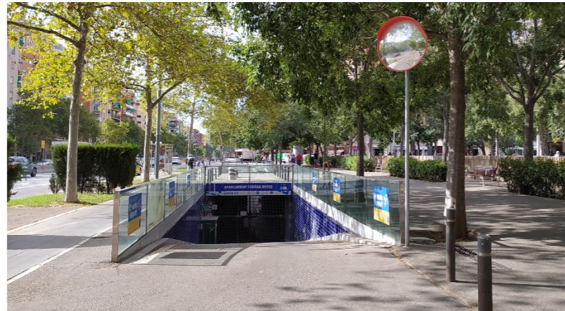
Aparcament amb doble accés – 09.03. Ferran Reyes (visita de camp)
